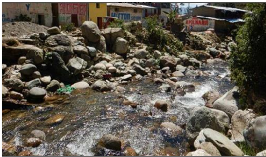
FOTO 01: se puede observar la colmatacion de material granular en el cauce de la Quebrada S/N (Rio Mnazano)
